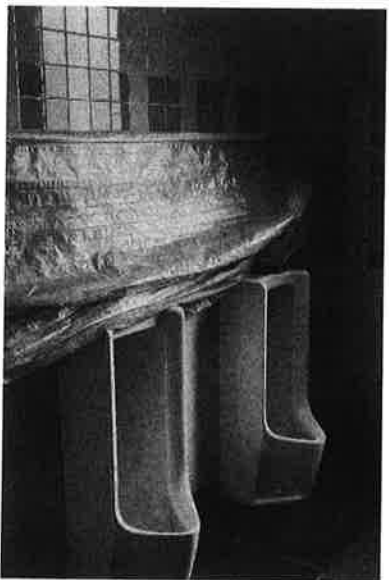
「学校等衛生環境改善」により行われたトイレの改修工事（2021年2月、北海道大学札幌キャンパス、著者撮影）。
